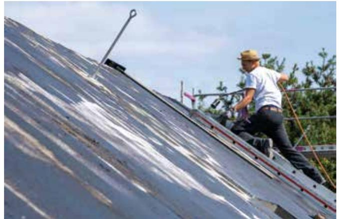
38 Grad Dachneigung und Stahlbeton-Fertigdach-Elemente waren die „Arbeitsgrundlage“ für die Dachdecker.
