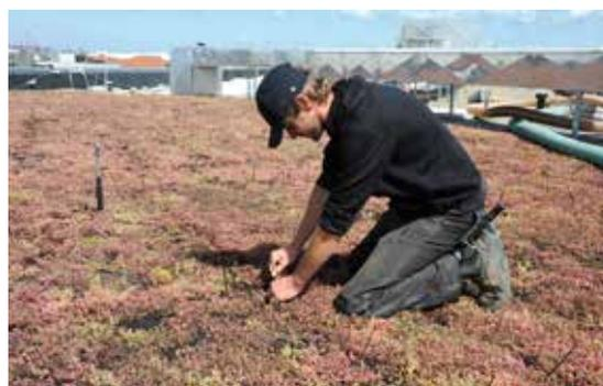
*Dachdeckergeselle Mirko Klotz verbindet die Sedummaten mit Kabelbindern, damit diese windgeschützt zusammenwachsen können.*
