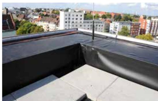
*Die Attika wird nicht nur einfach befestigt, sondern mit speziellen Klemmschienen fest verschraubt. Damit sie auch bei Sturm kein Spiel mehr hat.*
