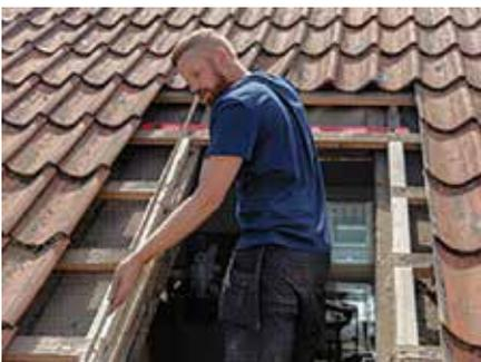
*Die Erweiterung der Fensterfläche beim Austausch eines alten Dachfensters wird bei den in der Vergangenheit häufig verbauten Modellen mit der Breite 66 Zentimetern durch das neue Unterelement deutlich einfacher.*
