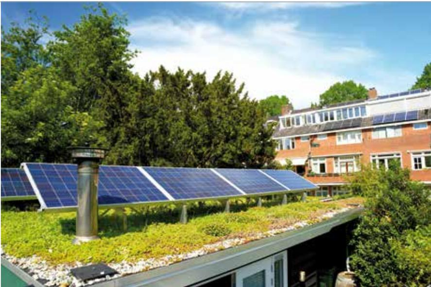
Die Kombination einer PV-Anlage mit einem Gründach erhöht den Stromertrag.
