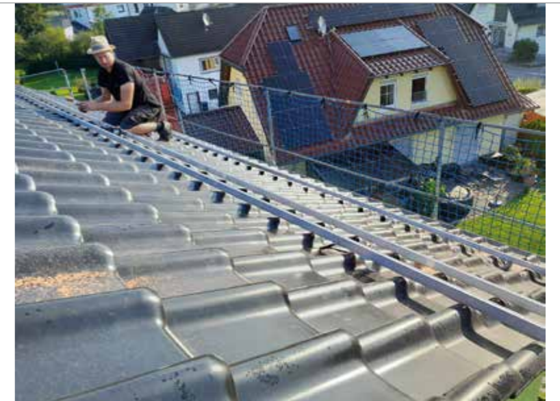
Nach dem Setzen der Dachhaken befestigen die Mitarbeiter die Schienen für die Module.
