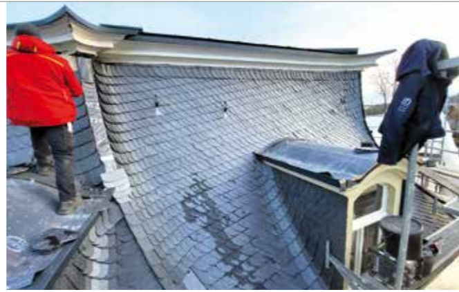
Ein Jahr Arbeit auf dem Dach
