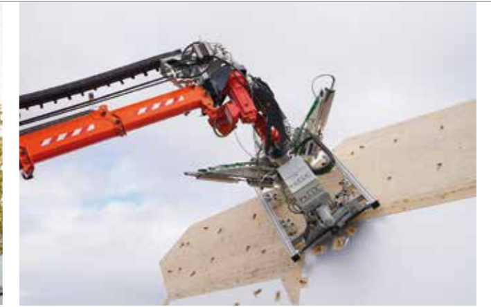
Der Roboter-Spinnenkran beim Einsetzen der Holzleichtbauteile.
