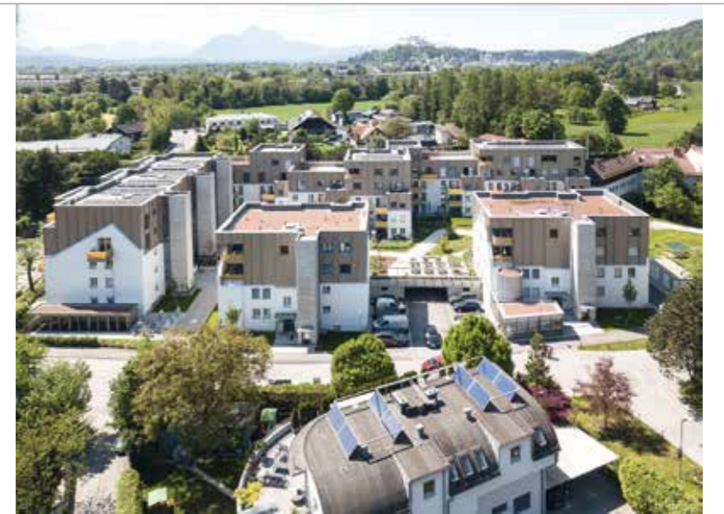
Dachaufstockung mit Flachdach – eine gute Möglichkeit, Wohnraum zu schaffen ohne Flächenverbrauch.
