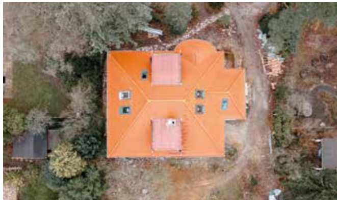
Eine sanierte Dachlandschaft in Berlin-Gatow, mit der Drohne aufgenommen.
