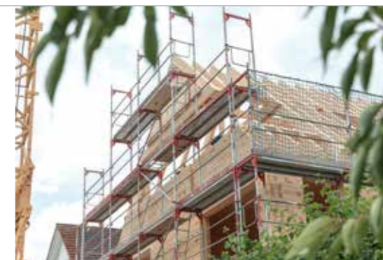
Das erste mehrgeschossige Wohngebäude mit Holzbausteinen wurde in Frankfurt realisiert.
