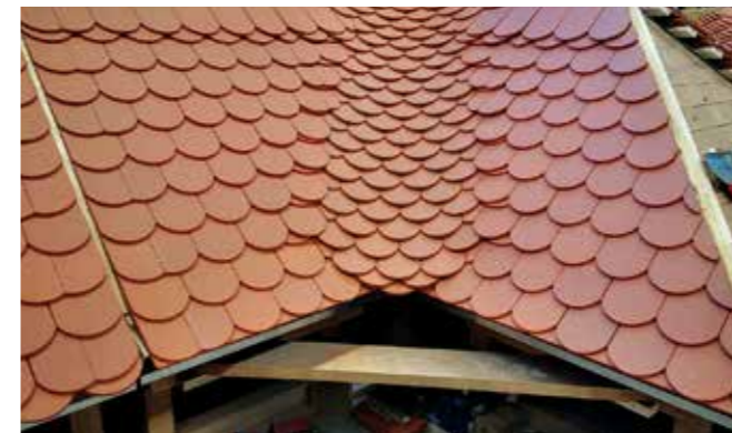
Das Meisterstück des Ex-Bankers, Biberschwanzdeckung mit eingebundener Kehle.
