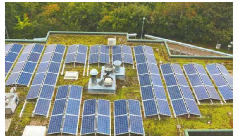
PV-Anlagen und Dachbegrünung sind wichtige neue Geschäftsfelder im Flachdachmarkt.
